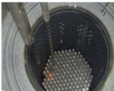
Рисунок. Загрузка ядерного топлива в активную зону реактора
