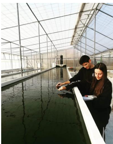
Рис. 2. ЦОК очистки городских сточных вод непрерывного действия с микроводорослями
