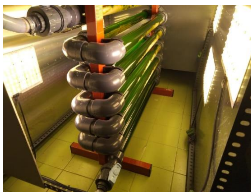
Рис. 3. Фотобиореактор очистных сооружений непрерывного действия с микроводорослями [2]
