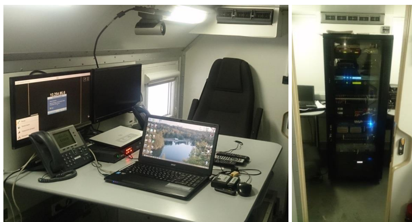
Рис. 1. Вид рабочих мест в оперативном отсеке (а); коммутационный шкаф (б)
